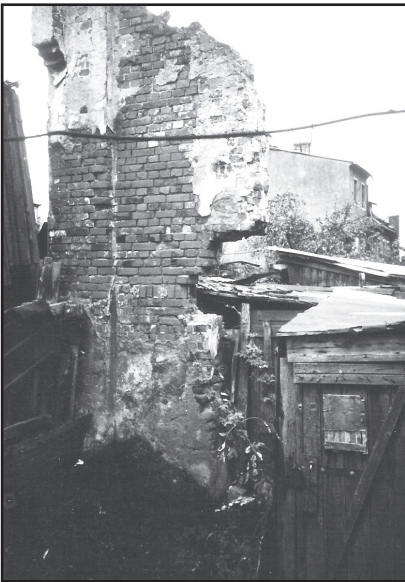
Abb. oben: Ruine des Gemeindehauses Kasernenstraße 7 im September 1993
